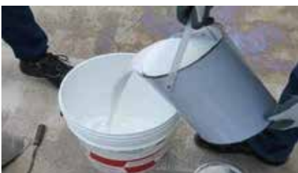
4. Pour Formdex AP01 (Component A) into an empty pail
